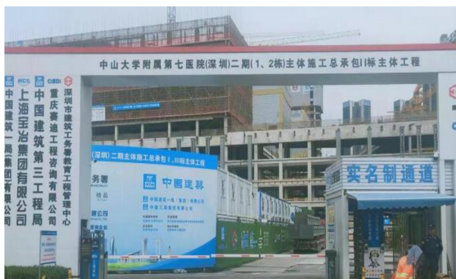
图 1 事故项目建设工程大门
