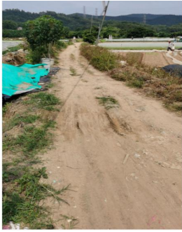
图30 现状土路照片
