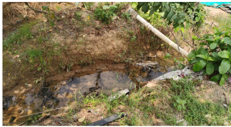
图33 现状泄洪渠道照片
