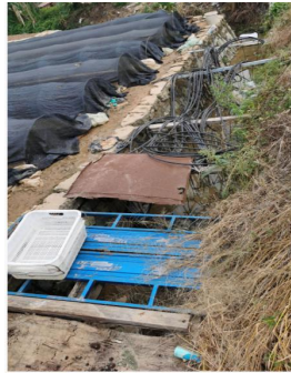
图31 排水沟堆放杂物照片
