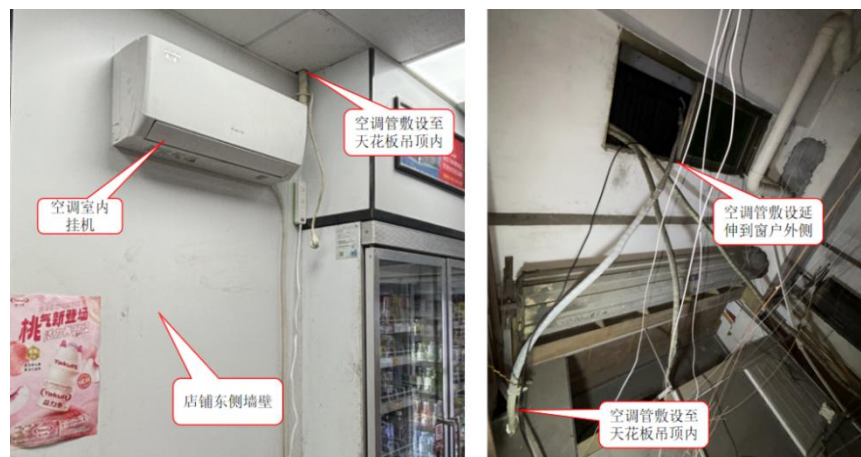
图 5 空调内机勘查图
