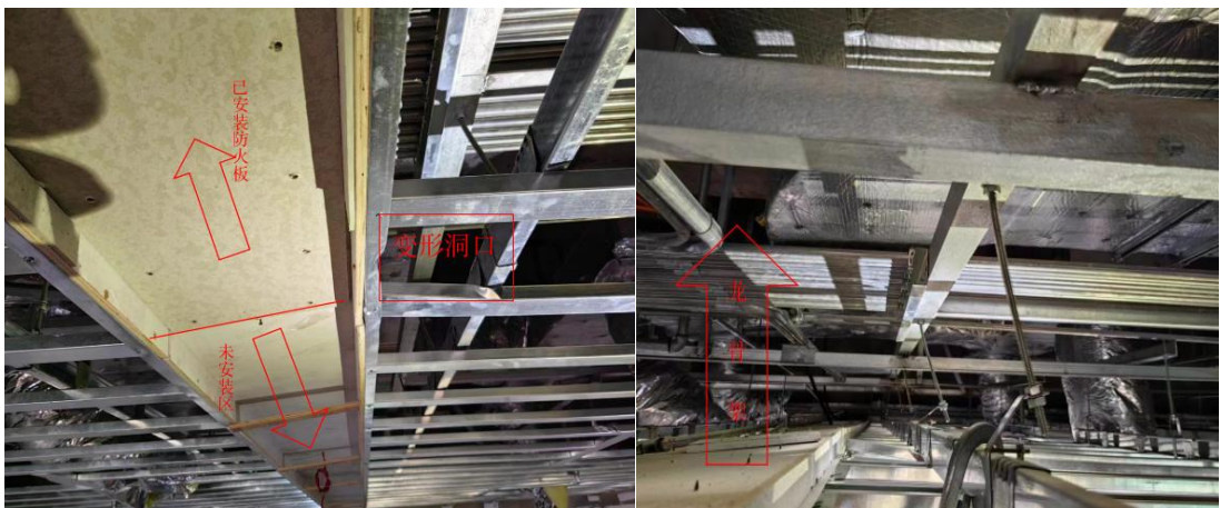
图 6 天花灯板安装情况和天花灯板上情况
