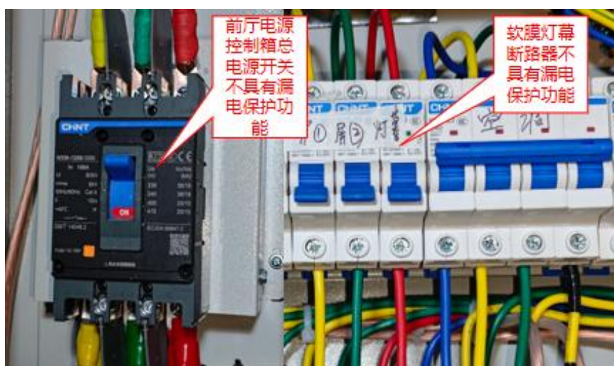
图 22 前厅电源控制箱（右侧部分防护盖板未拆除后）现场勘查图（二）
