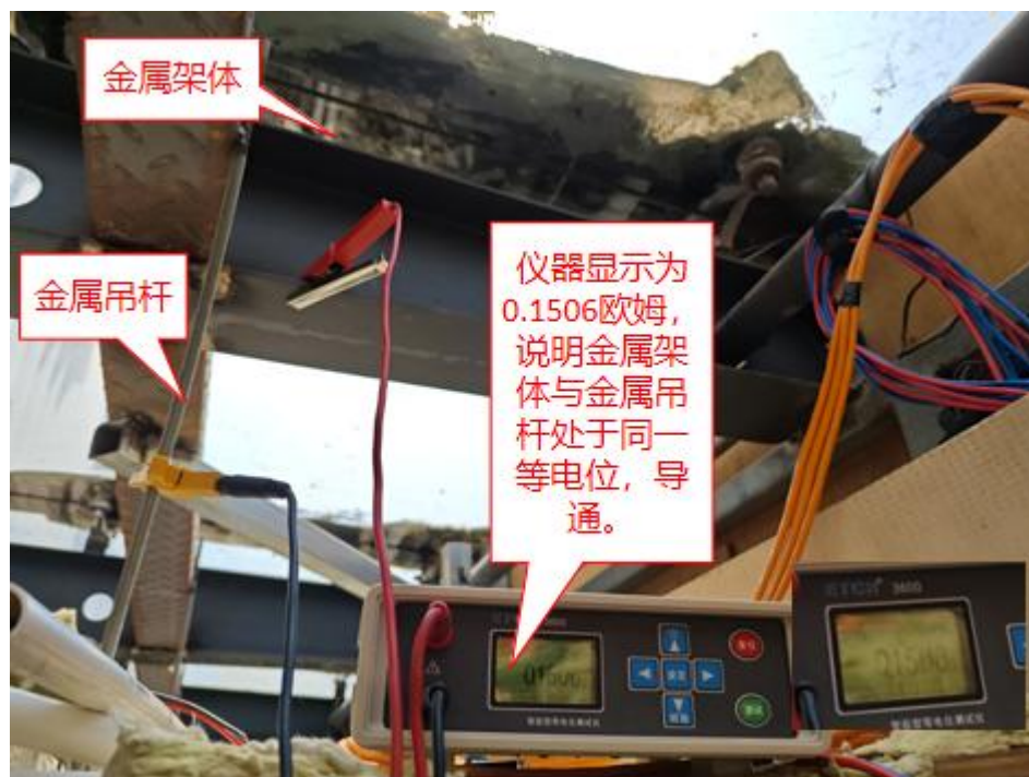
图 24 金属架体与金属吊杆等电位测试
