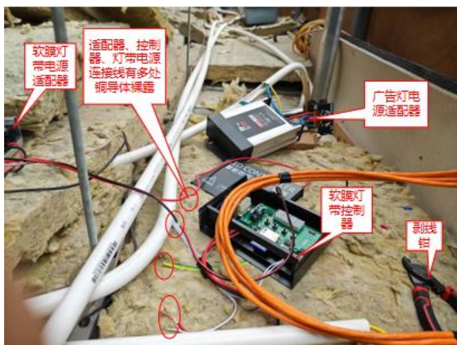
图 13 检修口东侧吊顶内勘查情况图
