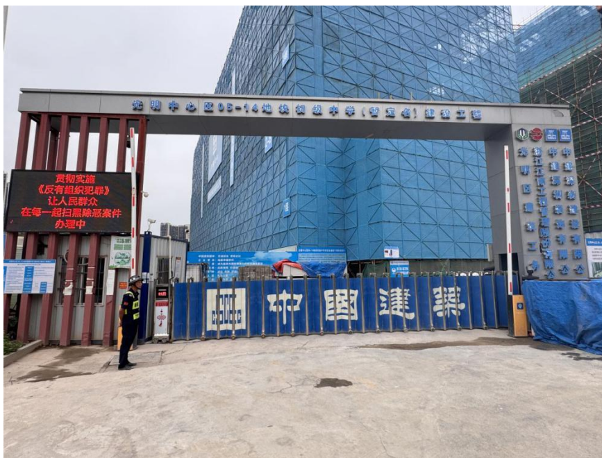
图 1 事故项目建设工程大门
