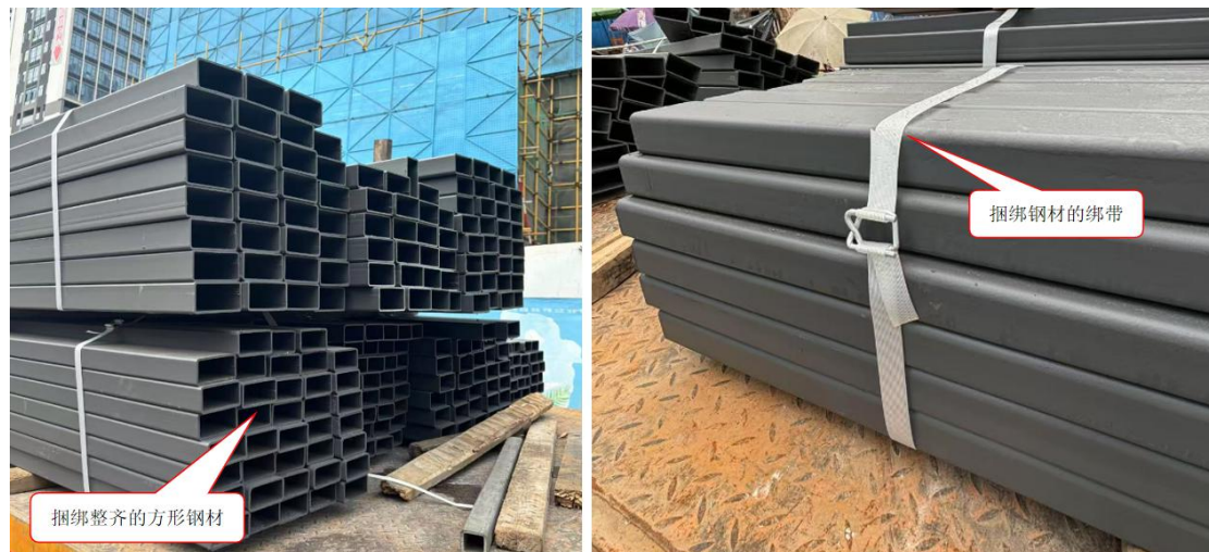
图 5 方形钢材捆绑示意图
