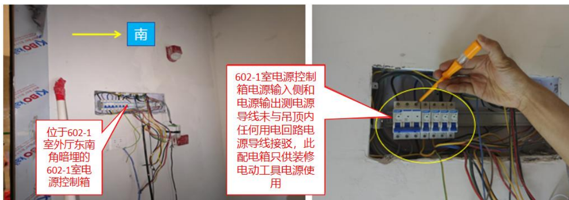
图 15 前厅照明控制箱现场勘查图
