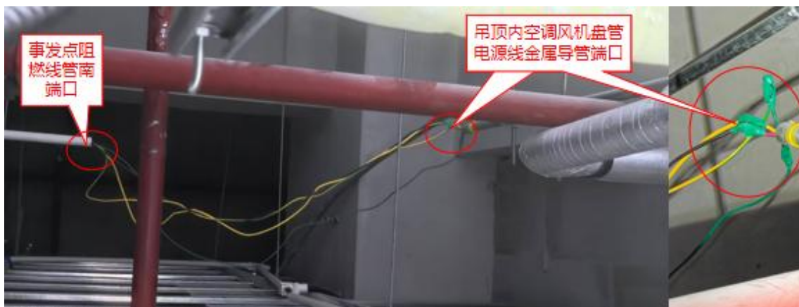
图 11 空调风机盘管电源线勘查图（一）
