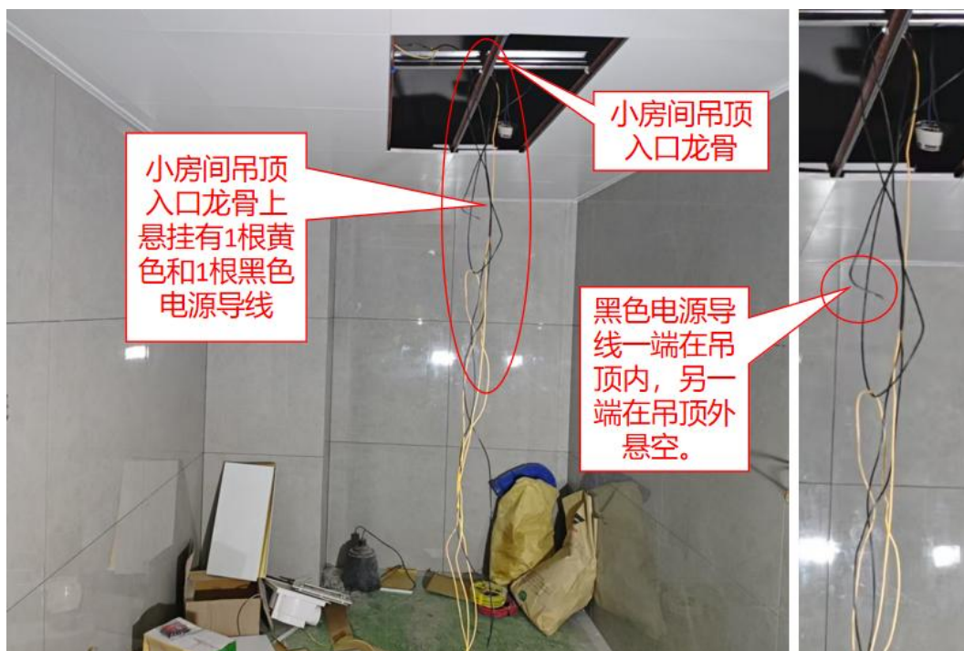
图 4 吊顶入口处勘查图
