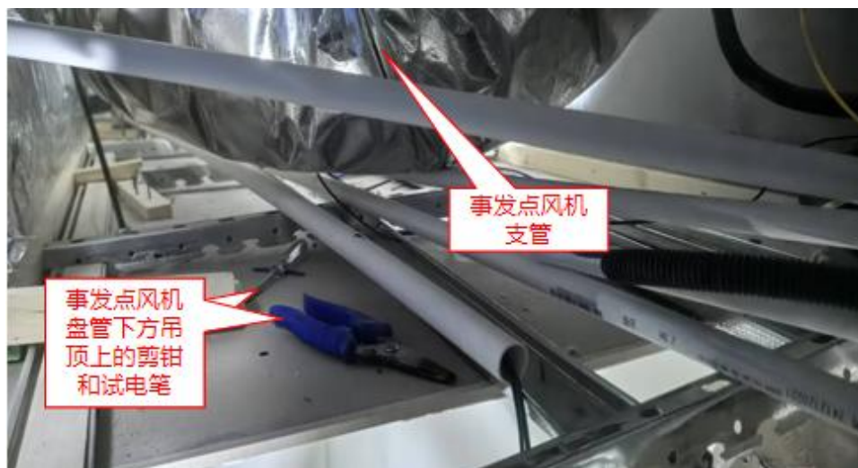
图 13 作业工具现场勘查图（一）
