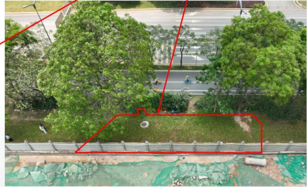
因排水管道施工接驳 需临时占用城市绿地257.28m 2
