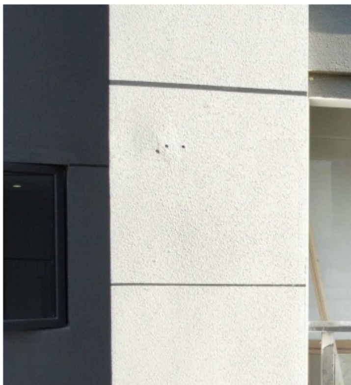
图 8 外墙上三个钻孔位
