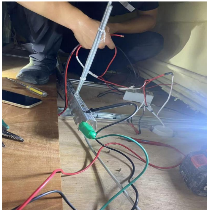
图 12 现场检测照片
