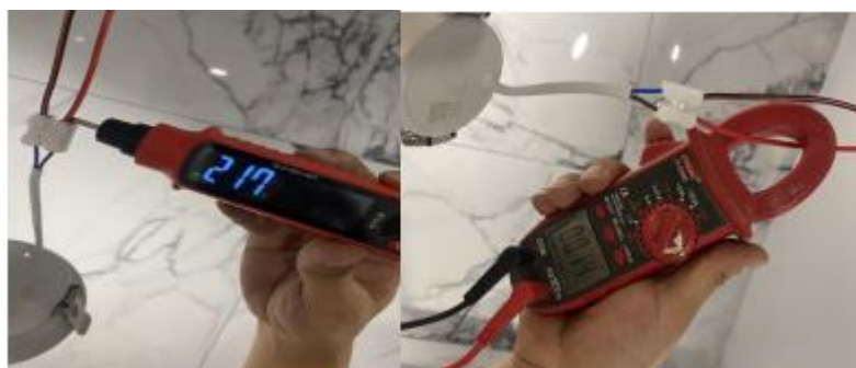
图 14 现场检测照片
