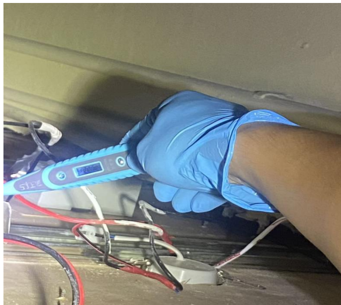
图 10 现场检测照片
