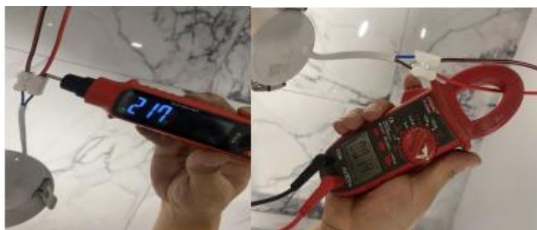
图 14 现场检测照片
