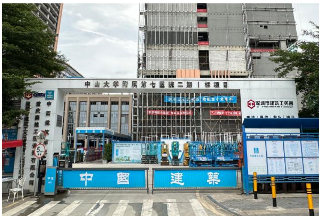
图1 事故项目建设工程大门
